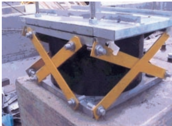
Isolatore in elastomero armato bloccato, accoppiato con dispositivo a scorrimento.
