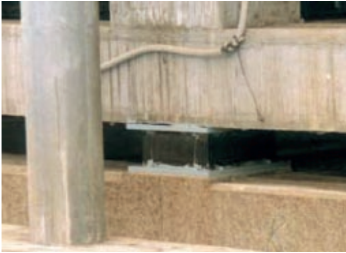
Isolatore in elastomero armato (fonte: TIS s.p.a., Roma).
