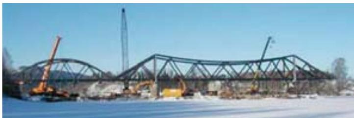
**Il ponte carrabile in lamellare più lungo del mondo realizzato sul fiume Glomma a Flisa in Norvegia:** ha una lunghezza totale di 181,5 metri con trave centrale di 71.
