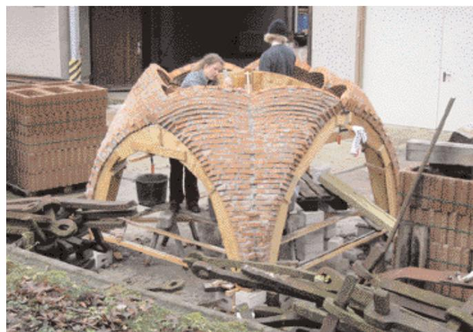
Prototipo sul modello di una volta gotica, costruito presso l’Università di Dresda, per studiarne il procedimento di costruzione.
