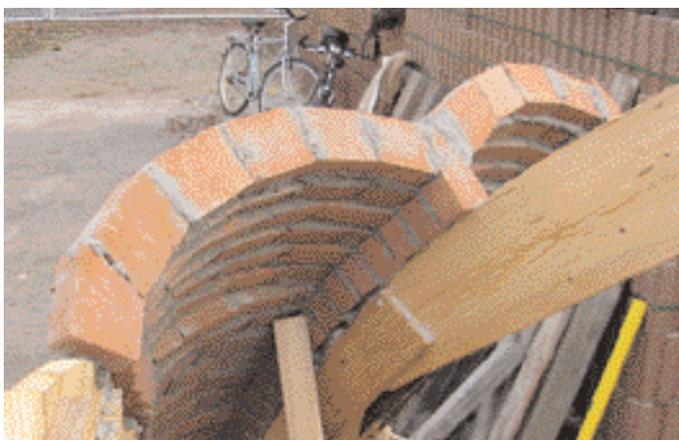
I singoli corsi sono disposti su piani inclinati: solo gli archi diagonali e perimetrali sono supportati da centine.
